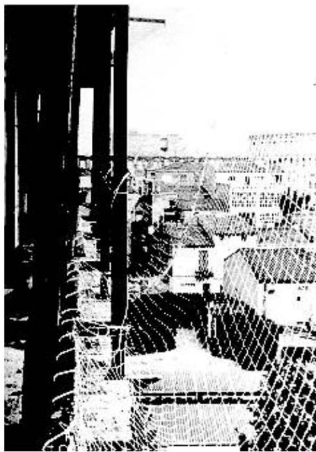
**Fig. 7: Barra auxiliar de amarre de la red**
