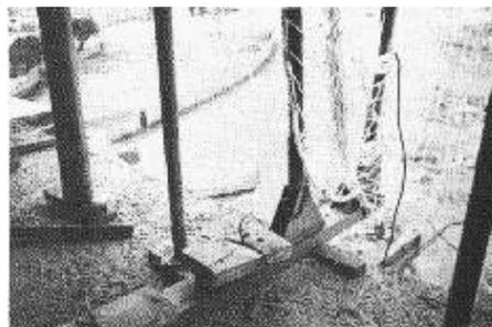
**Fig. 15: Soporte sujeto al forjado con alambres**
